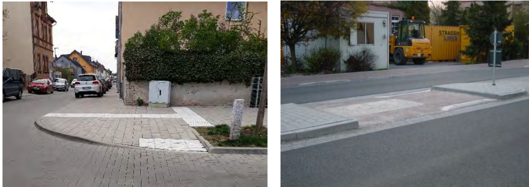
Abbildung 65: Beispiele zu barrierefreien Angeboten im öffentlichen Straßenraum (barrierefreier Einmündungsbereich/ barrierefreie Mittelinsel)
