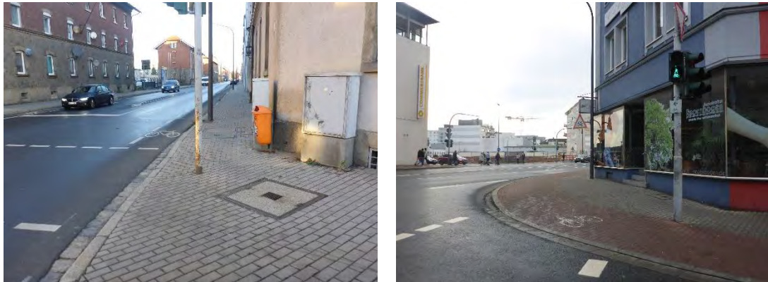
Abbildung 24: geringe Aufstellflächen an Lichtsignalanlagen (Prinz-Ludwig-Straße/ Bahnhofstraße)
