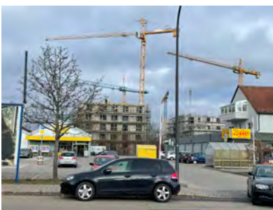
Abb. 29 | Nachverdichtung im zentralen Stadtbereich, „Neue Naabwiesen“ an der Dr.-Pfleger-Straße
