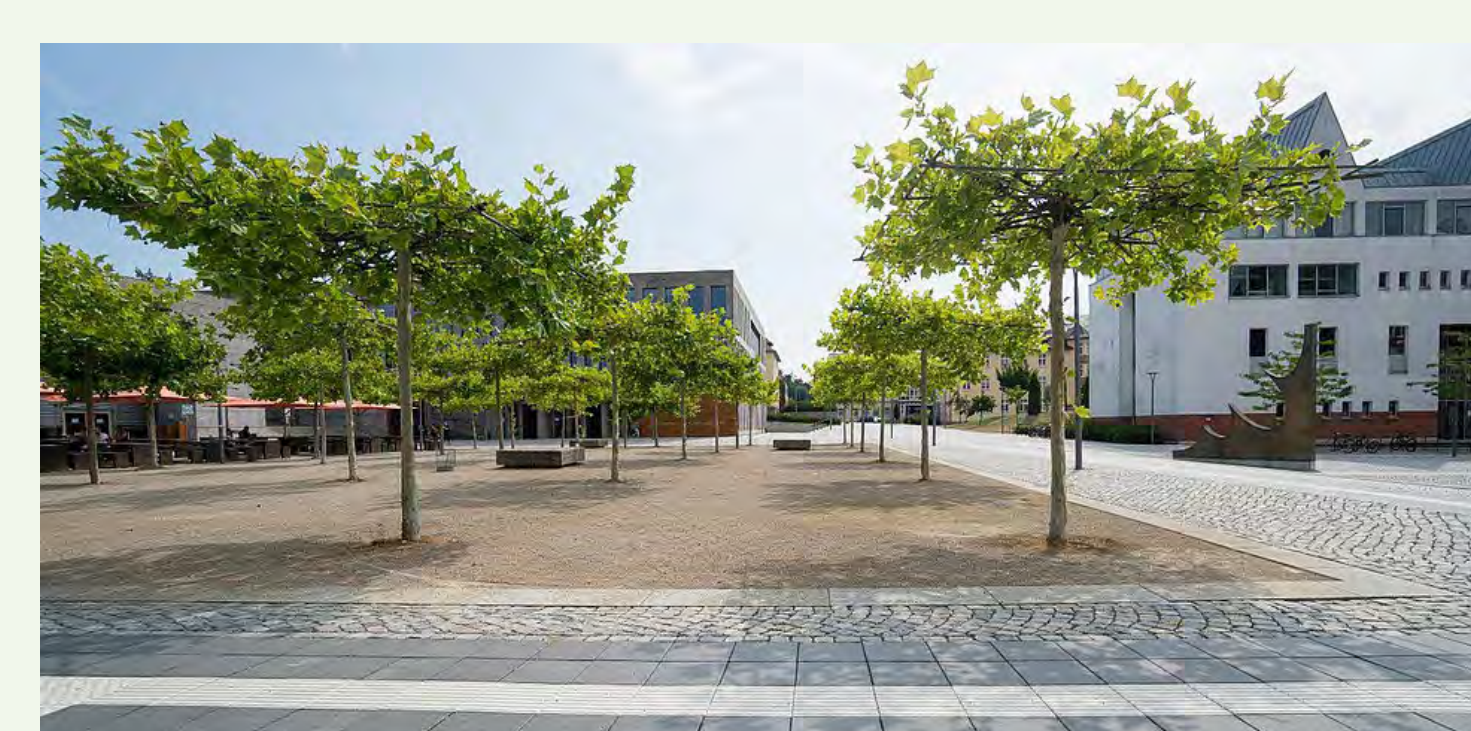
Platzintarsien aus wassergebundener Decke
